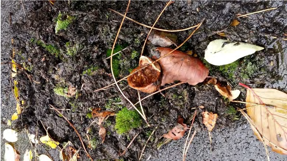
Figuur 77: Bijengeveegd materiaal op het platte dak: noten, mos, bladeren, dennennaalden Analyse van dit materiaal in het laboratorium van de BDB geeft 0,039 mg/kg ds aan PCB's (som 7), wat hoger is dan de richtwaarde van 0,033 maar nog wel lager dan de bodemsaneringsnorm voor kleintuingebied van 0,044 mg/kg ds aan PCB's (som 7). Norm voorgesteld door VITO in 2005.
